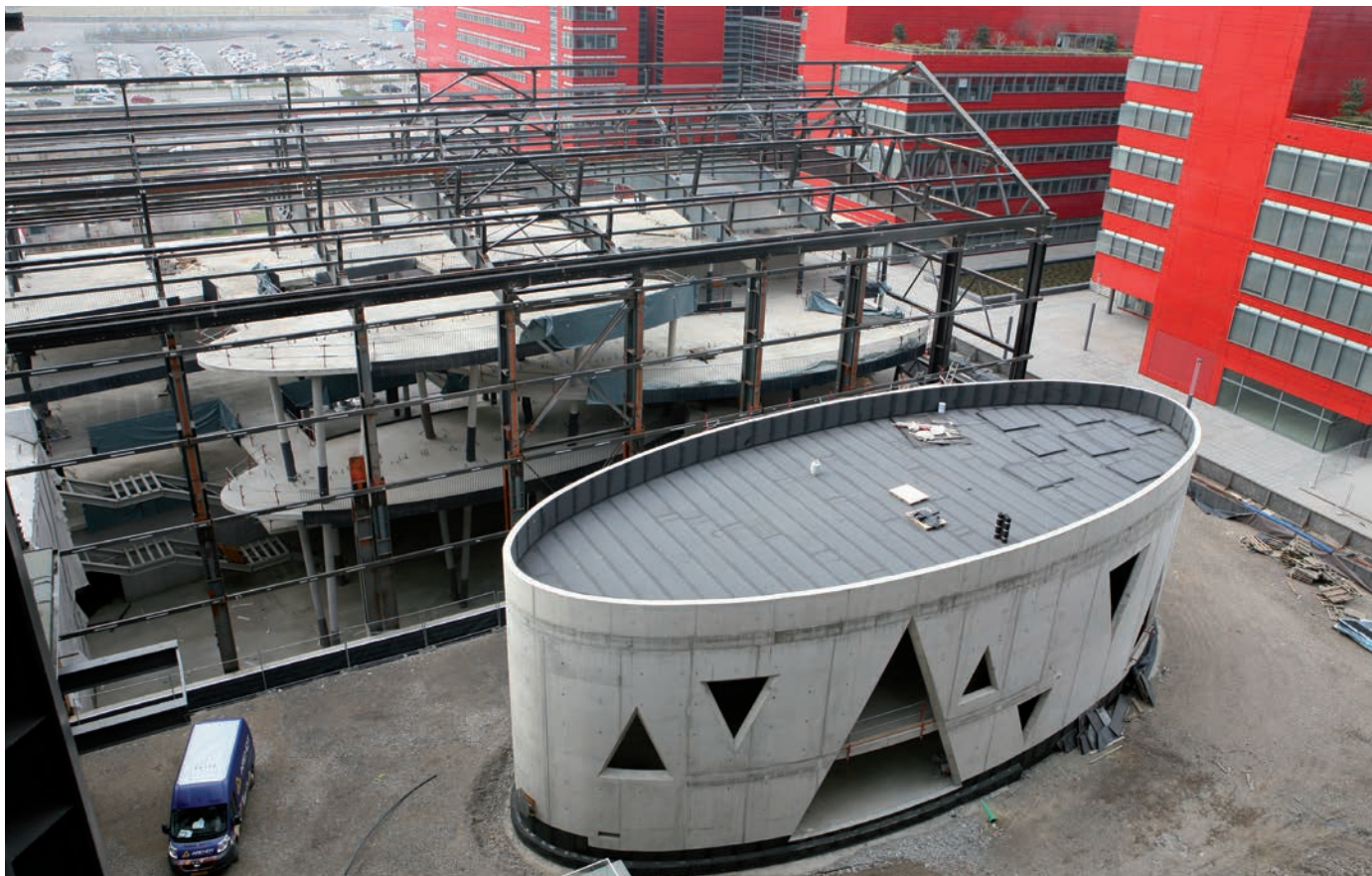
Vue sur le pavillon d'entrée de la bibliothèque
