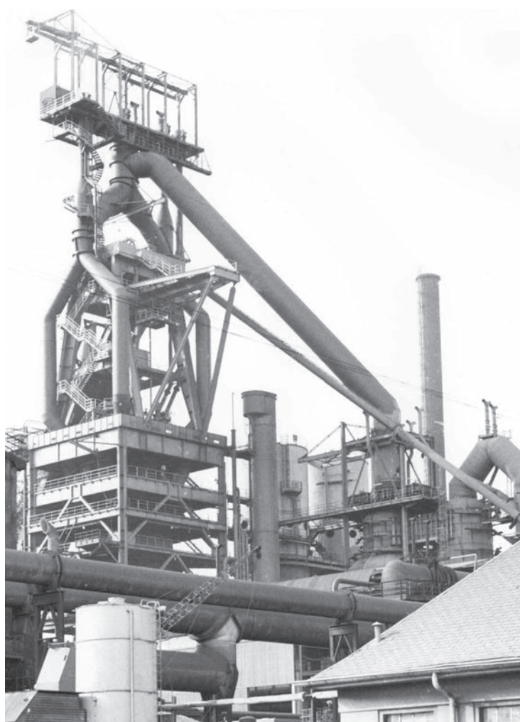
En 1975, le gueulard à cloches du haut fourneau B fut remplacé par un gueulard sans cloches
