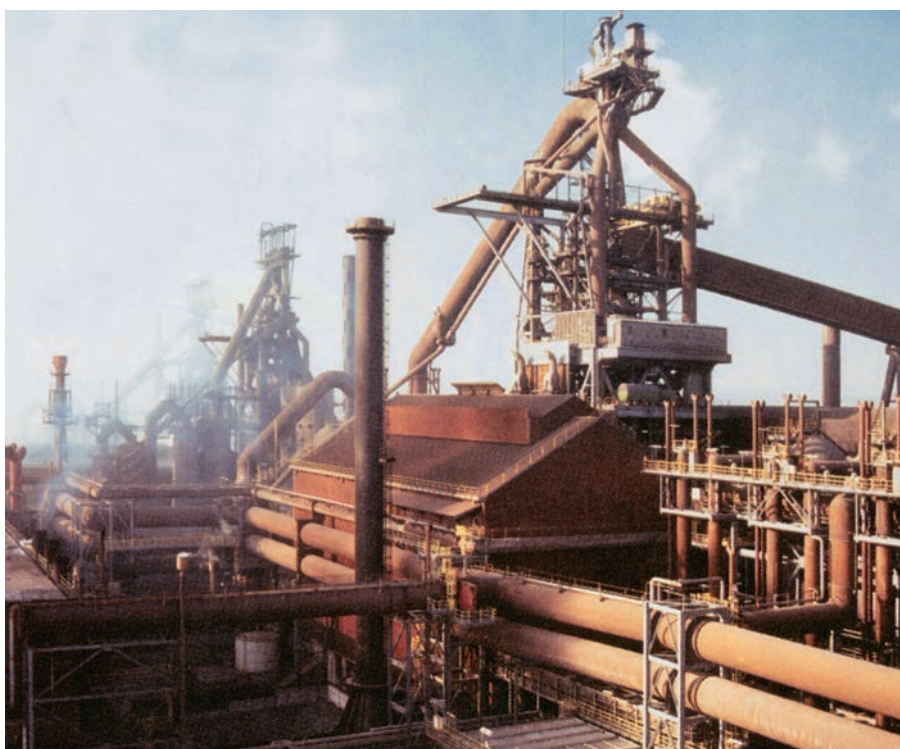
Le haut fourneau C, le plus puissant des trois
