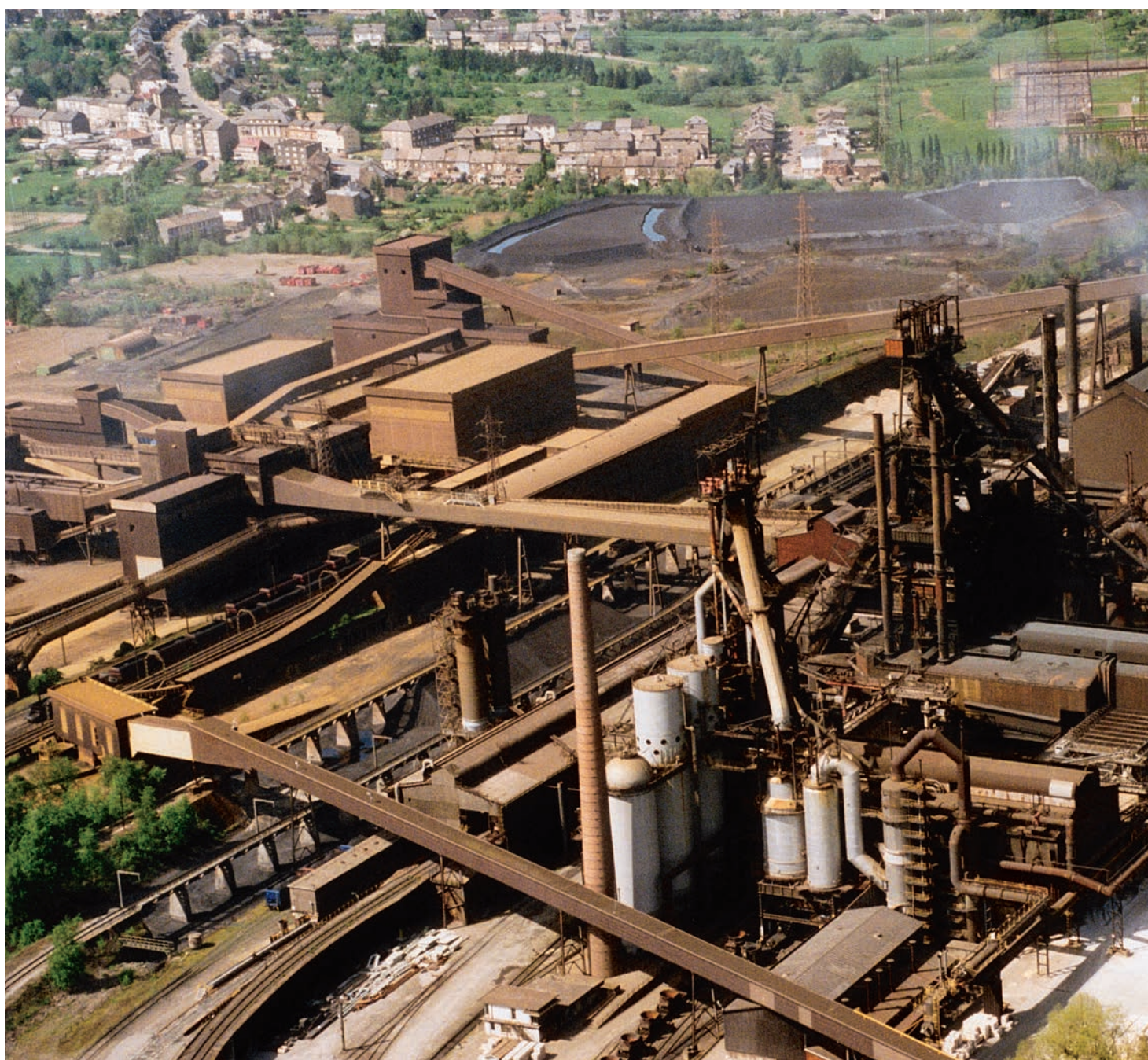
Les trois hauts fourneaux A, B, C de Belval mis en service respectivement en 1965, 1970 et 1979
